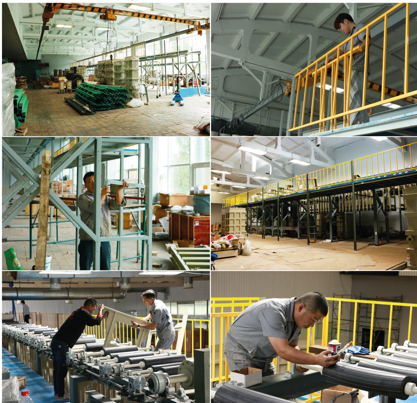
Монтаж нового оборудования в цехе 10 специалистами из Китая, июль 2024 года
